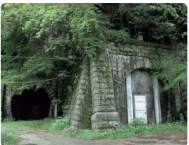
① 旧逢坂山トンネル
