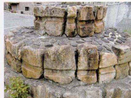
■「京津国道改良工事記念碑」の基壇に利用された車石
